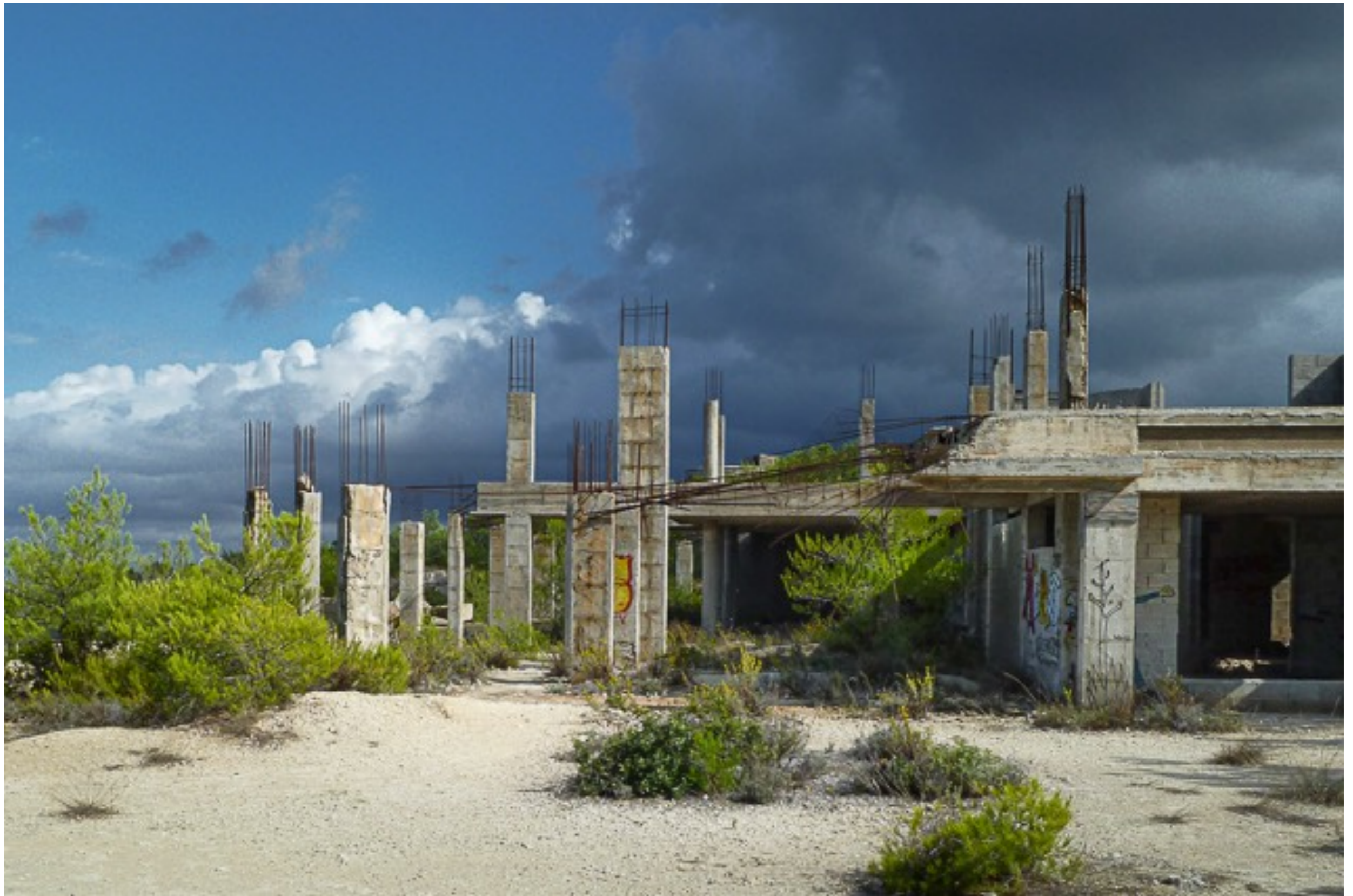
5 - Baustelle - Pia Müller-Spitzfaden
